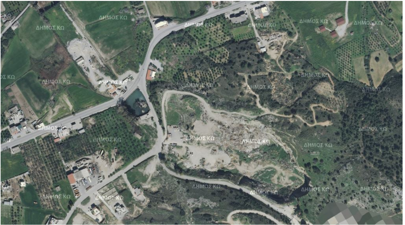
Εικόνα 56: Εργοτάξιο του Δήμου στο Πυλί
